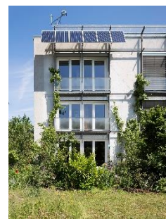
Das weltweit erste Passivhaus in Darmstadt-Kranichstein. © Peter Cook
