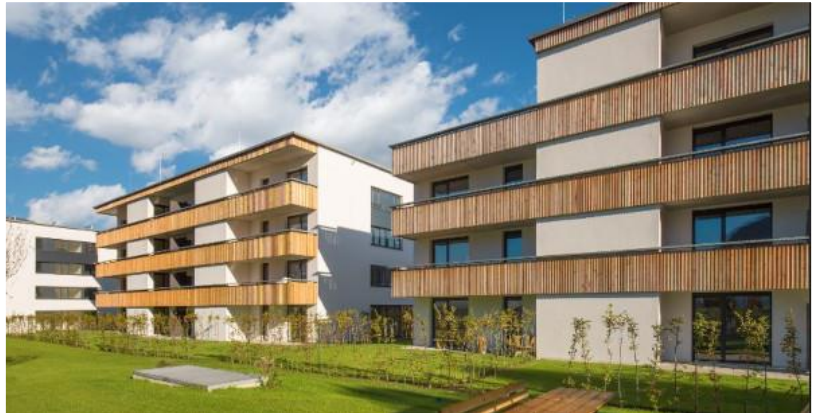
Energieeffizient und kostengünstig: Sozialer Wohnungsbau der Baugesellschaft Neue Heimat Tirol in Kufstein. © NHT
